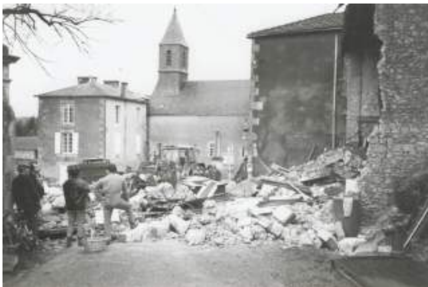
Coulée de boue survenue en janvier 1995 dans le bourg
