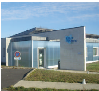
Centre d'hydrocurage de Gençay
