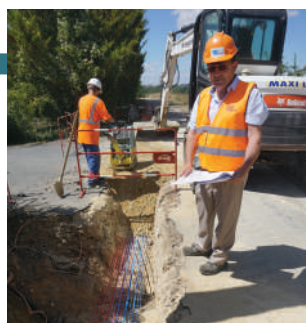
Suivi de travaux par la DIRE - 14/08/2018
